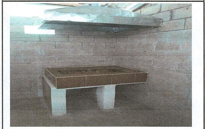
Foto 4: Mejoramiento estructura de techo del patio
